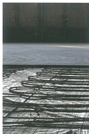
10, 12 | Dwukondygnacyjny hol z centralnymi schodami z betonu architektonicznego doświetlono świetlikiem 11 | Montaż ogrzewania podłogowego
